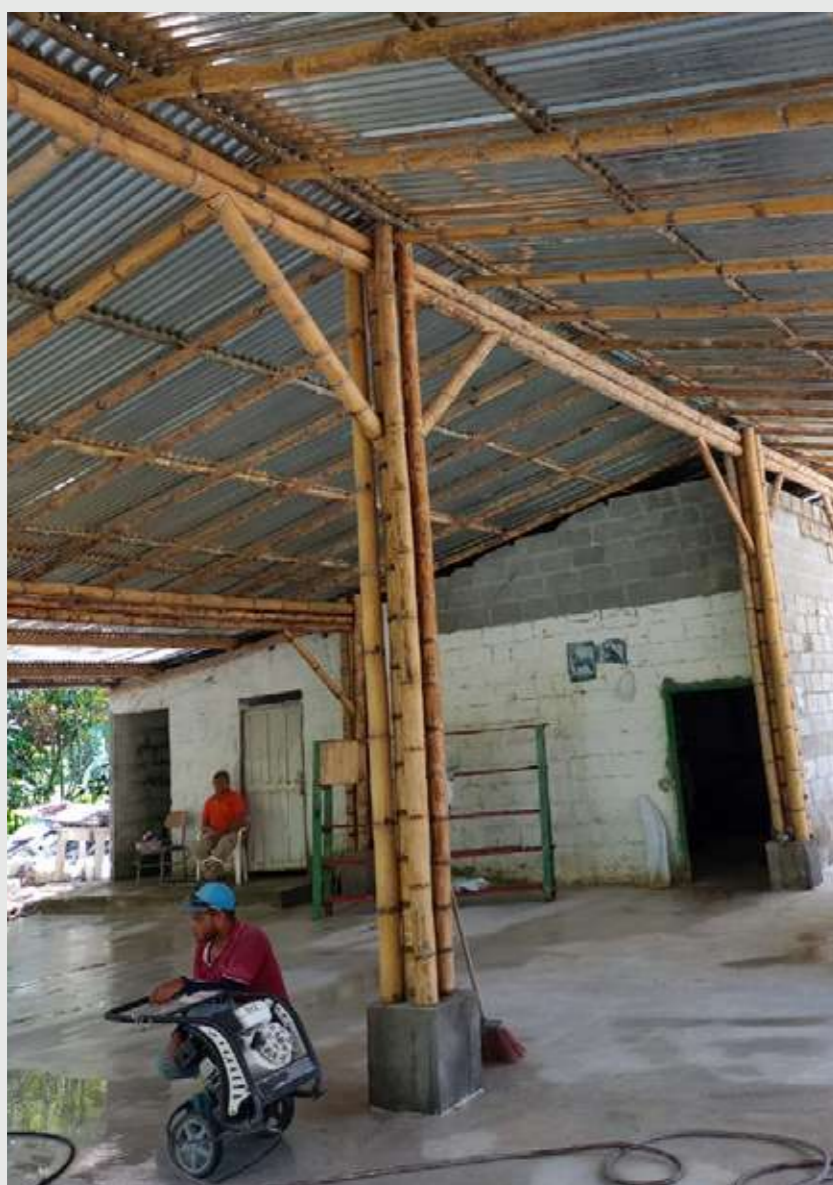
Apoyo con materiales para adecuación de pisos. Calidra Colombia.
